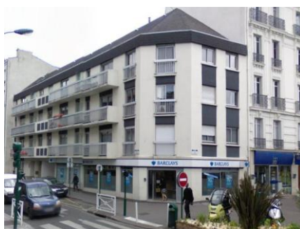
Agence Barclays – rue de Strasbourg à VINCENNES (94)
