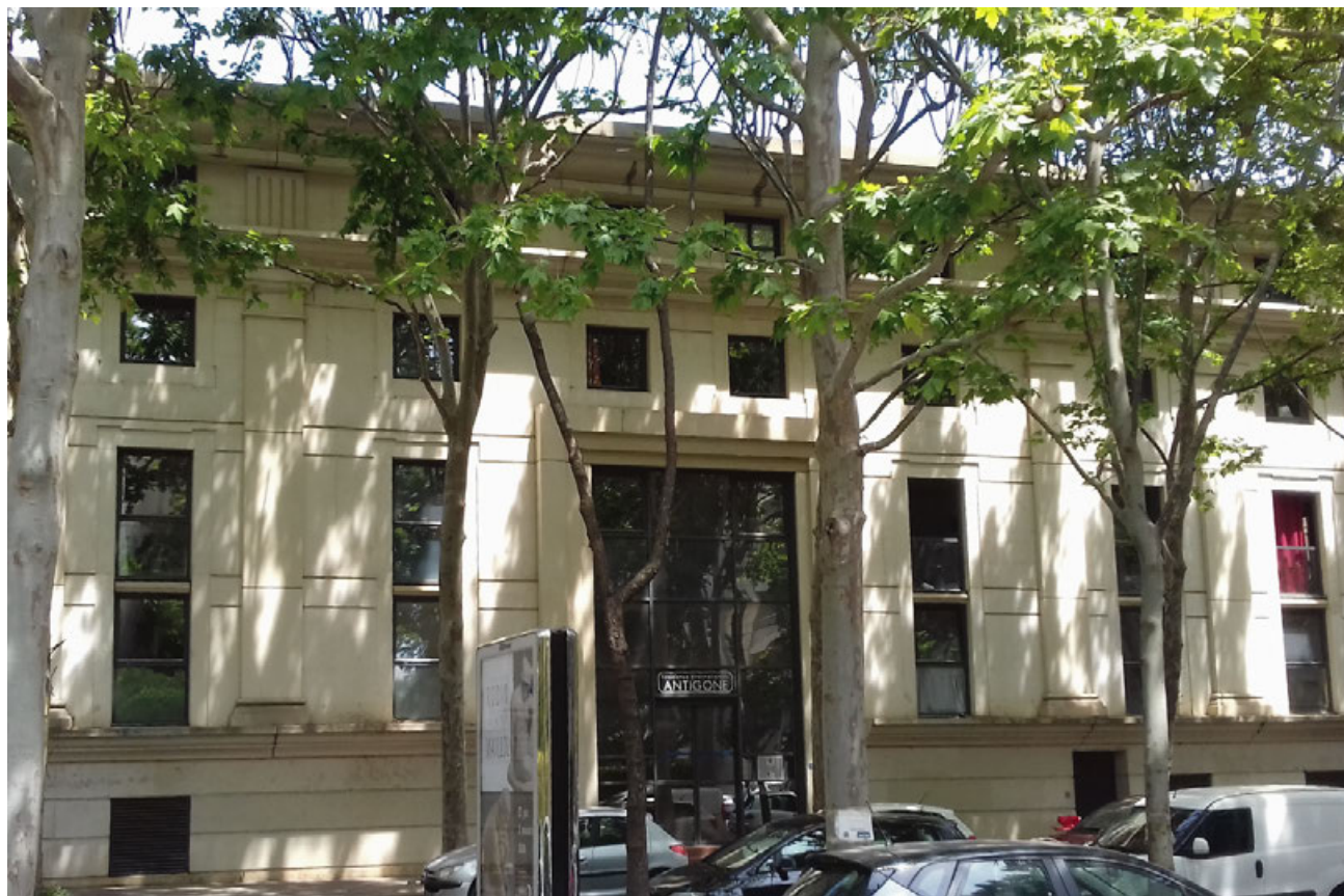
43 rue de Thèbes-185 allée du Nouveau Monde - Montpellier (34) Locataires : Région Occitanie et Direction Départementale des Impôts
