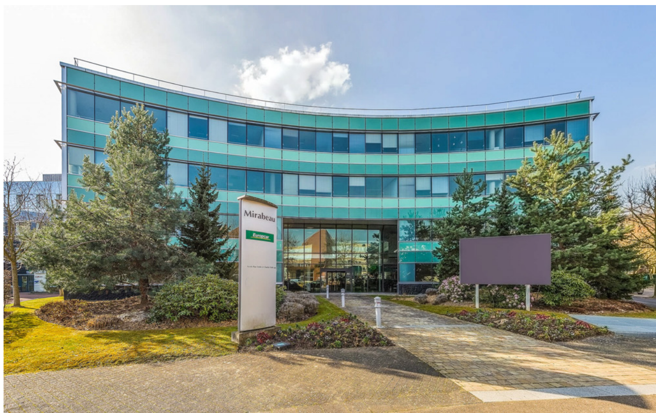
5 place des Frères Montgolfier - Guyancourt (78) Locataire : Socotec
