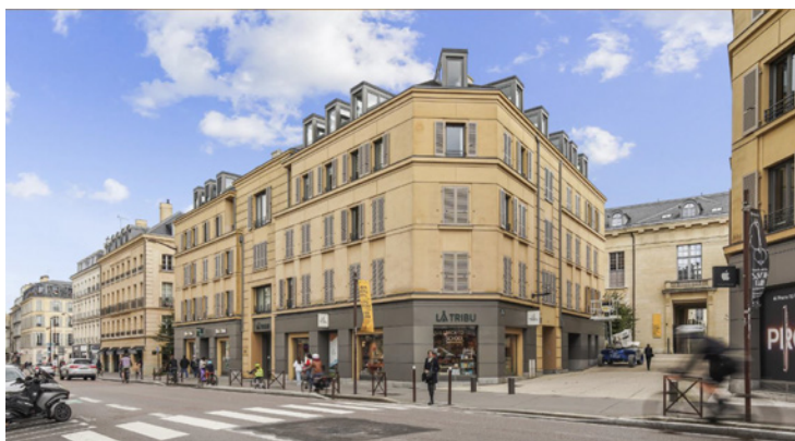
Ensemble de cinq commerces de pied d'immeubles - Rue du Maréchal Foch - Versailles (78)
