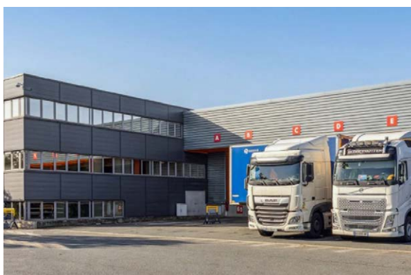
Entrepôt logistique (Bègles)
