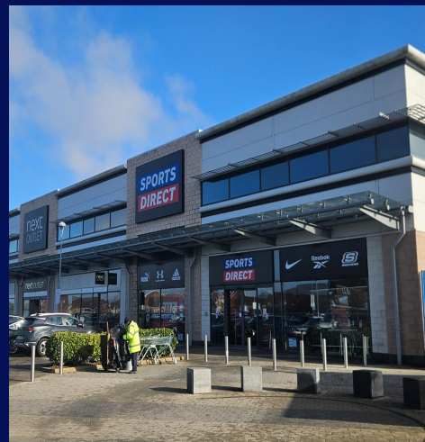
Warwickshire Shopping Park - Coventry (Royaume-Uni) Crédit photo : Interne
