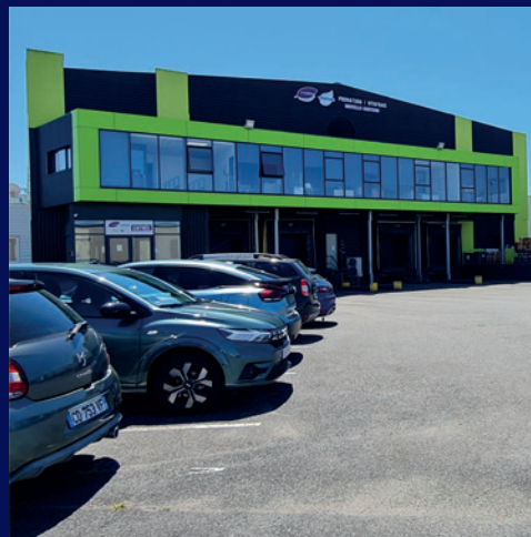
Zone d'activité - Vayres (France) Crédi photo : Ressource
