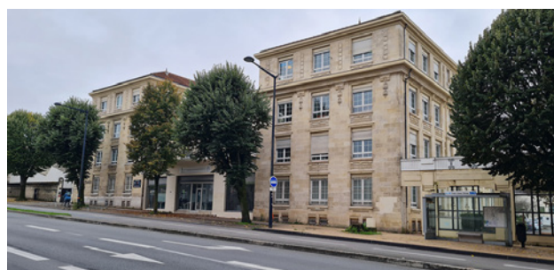
Immeuble de bureaux multilocataire Le Plaza - Bordeaux (France) Crédit Photo : Ressource
